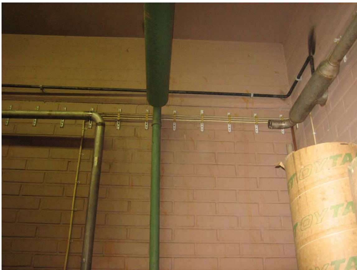
Demonterad förbigångskoppling mellan dricksvatten och tekniskt vatten. Foto: Hans Hagelin, VAKA
