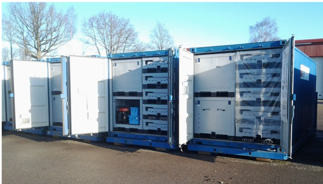
Figur 16. VAKA:s 1 m 3 nödvattentankar med tillhörande utrustning lagras i containrar byggda på lastväxlarflak.
